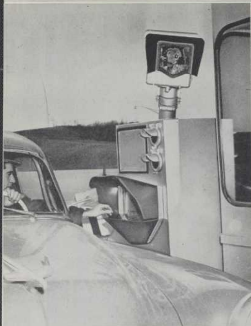
LE COLLECTEUR-ROBOT DE PÉAGE REÇOIT LA MONNAIE QUE LUI VERSE L'AUTOMOBILISTE. SI CE DERNIER TENTE DE LE TRICHER, L'APPAREIL MET EN BRANLE UNE SONNERIE D'ALARME, DES SIGNAUX LUMINEUX, ET PREND MEME UNE PHOTO DE LA PLAQUE ARRIERE DE L'AUTO-MOBILE.
