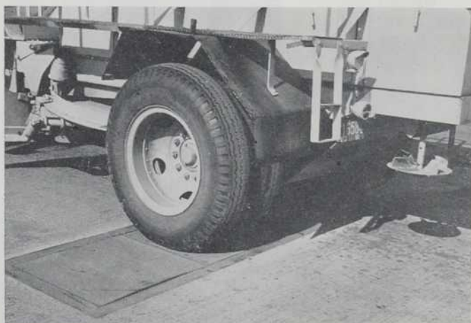
LA PLATEFORME D'UNE BALANCE ELECTRONIQUE, ENFOUEE DANS LA CHAUSSEE, PEUT ENREGISTRER LE POIDS D'UN CAMION FILANT MEME A 60 MILLES A L'HEURE.
