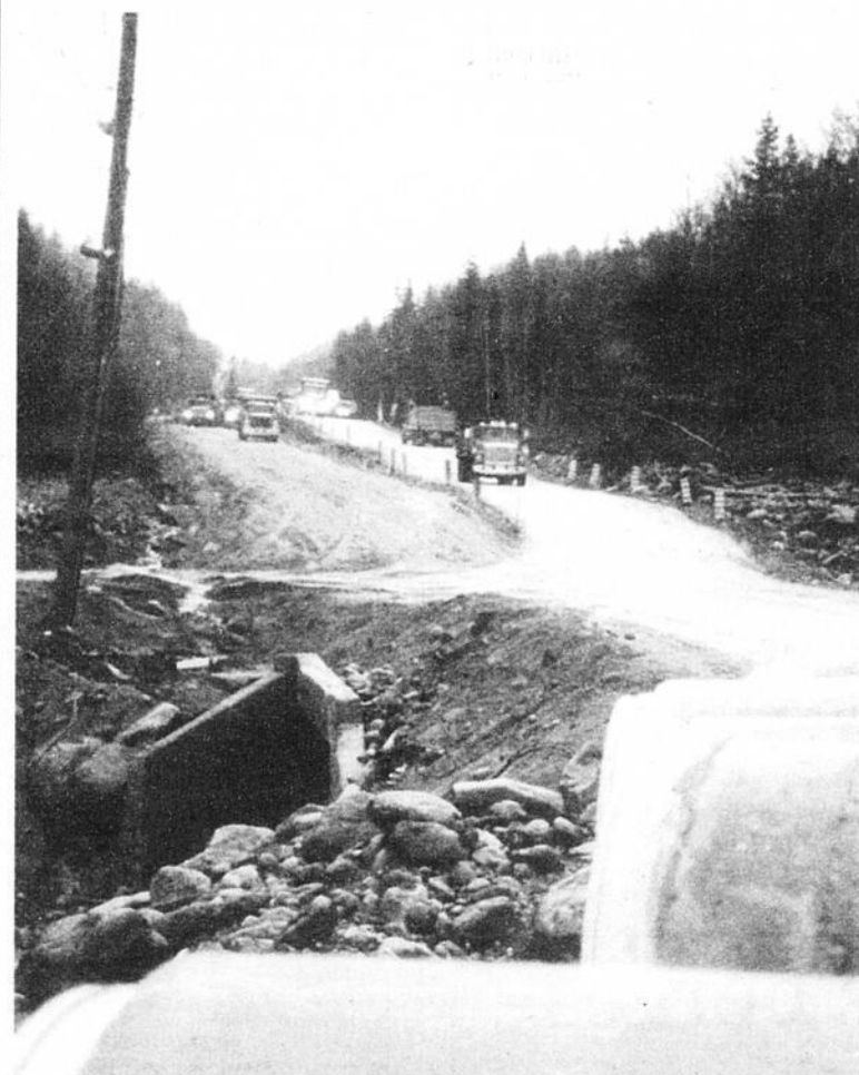
CHANTIER - Comme on peut le voir sur cette photo, le secteur de L'Anse-Saint-Jean est un véritable chantier. Tôt lundi matin, les camions circulaient.
