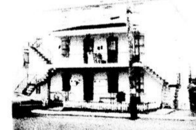
BLOCS A LOGEMENTS
