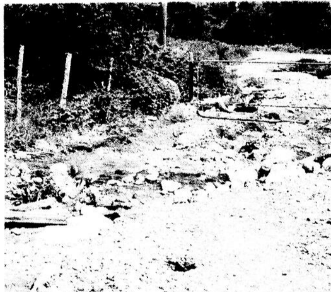
Une barrière sert normalement à interdire l'accès aux autos. Cependant, comme on peut le constater l'état du chemin suffirait à jouer ce rôle.
