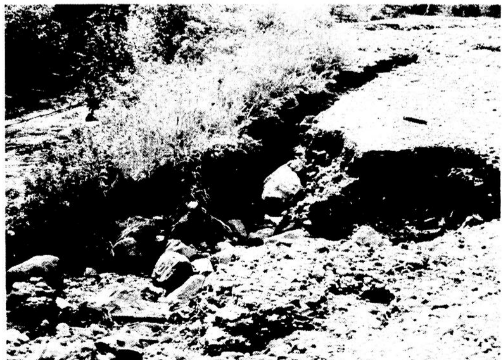
A certains endroits, l'eau a fait des crevasses dont la profondeur atteint plus de trois pieds. Même si le chemin était en gravier, la force destructrice de l'eau en est venue à bout.
