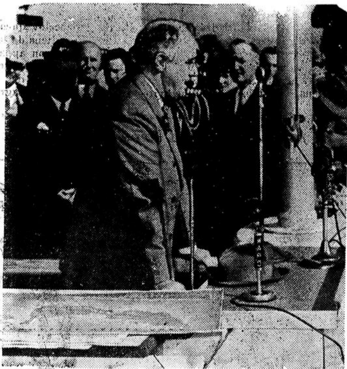
En route pour Warm Springs Ga., pour une visite du jour de Reconnaissance, le Président Roosevelt s'arrêta à l'écluse de Chick- amauga pour en inspecter la construction. C'était la première vi- site du Président à l'écluse.
