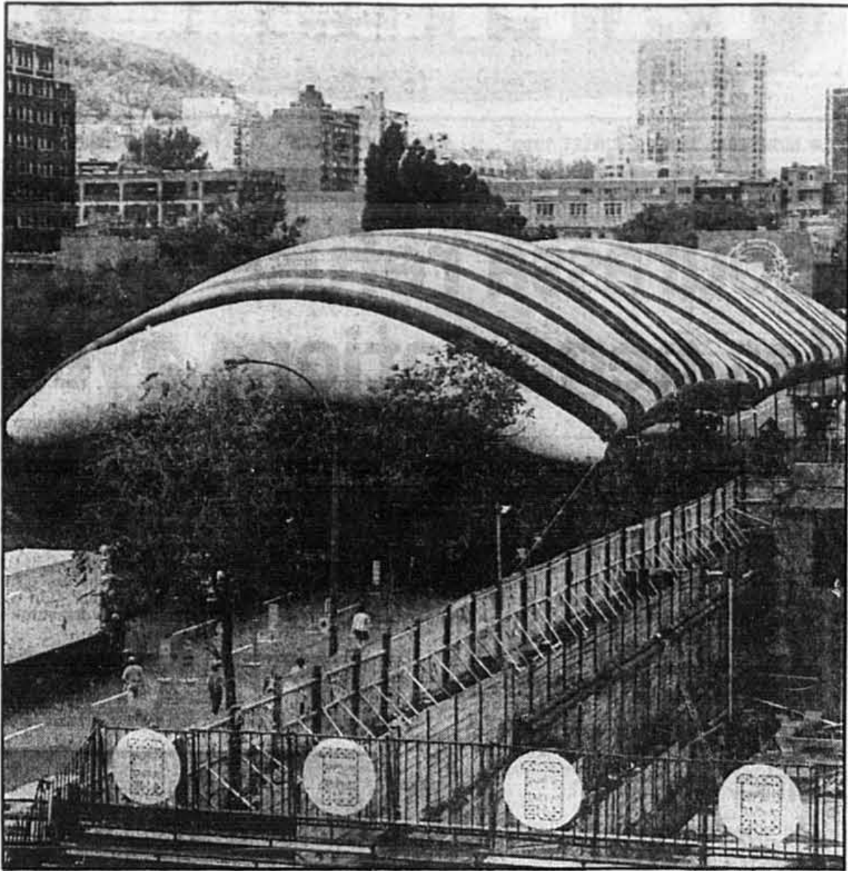
Le toit de la rue Jeanne-Mance est fait de 100000 pieds carrés de toile de polyester enduit de vinyle, sans aucun renfort métallique. Au centre, son épaisseur atteint 12 pieds.
