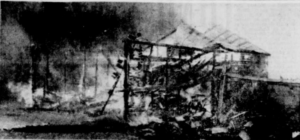
Pertes totales. — Un incendie d'origine inconnue a détruit de fond en comble le garage de M. Norbert Pépin, à Omerville. Les pertes seraient évaluées à $1,500. On
