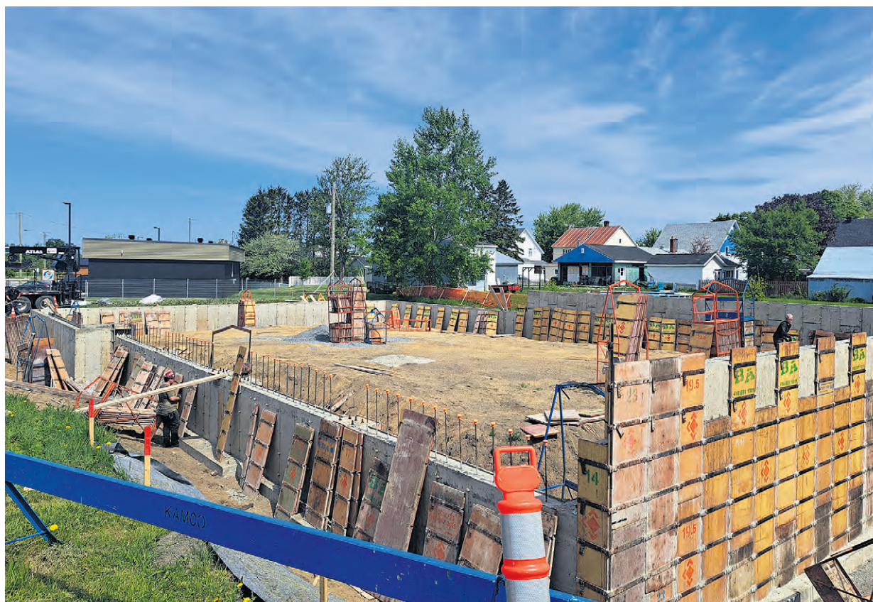
Les travaux sont commencés et devraient se terminer à la fin de l'année 2024.
