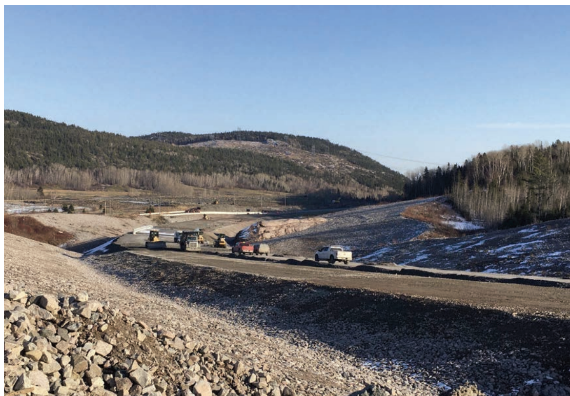
Les travaux de reconstruction de la route 138 dans le secteur de la côte Arsène-Gagnon aux Bergeronnes sont en pause hivernale depuis la fin novembre. Photo courtoisie
