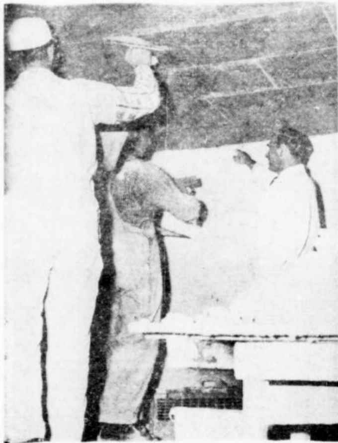
L'atelier de plâtre — Faire les joints à un plafond n'est guère facile semble dire ce jeune apprenti à M. Grégoire Roy, instructeur de l'atelier de plâtre, qui lui montre comment procéder. Ces deux apprentis appliquent du crépi à un plafond d'une pièce affectée aux fins de cet atelier.
