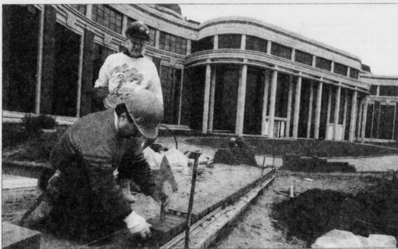
L'aménagement extérieur coûtera à lui seul 1,3 million $. Les fonctionnaires déménageront en avril 1996.
