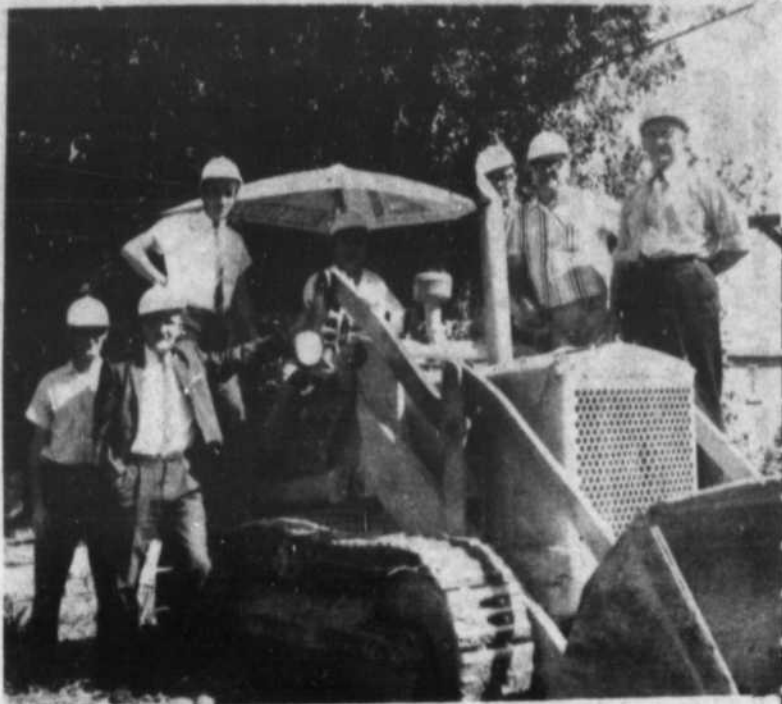
DEBUT DES TRAVAUX. Cette photo nous montre les débuts des travaux d'agrandissement à la Salle des Chevaliers de Colomb de Gatineau, Conseil 2880. On reconnaît sur cette photo MM. Roland E. Groulx, Grand Chevalier, Paul Bureau, secrétaire-financier, René Séguin, Fernand Miousse, Lucien Bazinet, Gervais Bélanger, le contracteur, et Léandre Pilon. (Photo Rolland Lafrance)
