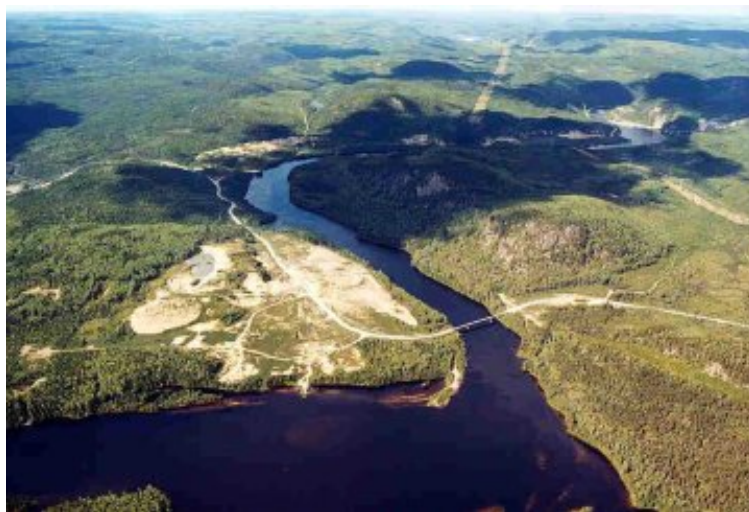
Vue sur le réservoir Manic 2, au sud de Manic 3 - Photo Hydro-Québec
