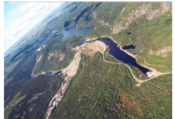
Vue aérienne du réservoir Outardes 3 - Photo Hydro-Québec
