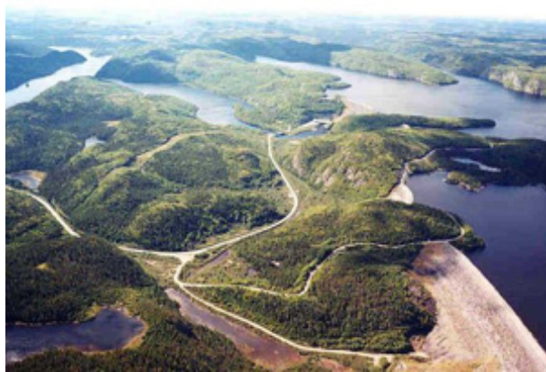
Vue aérienne du barrage Outardes 3 - Photo Hydro-Québec
