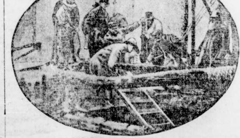
LE DESASTRE DU THEATRE DE BOYERTOWN. — Le petit escalier de cinq marches où pas moins de 26 cadavres ont été trouvés.
