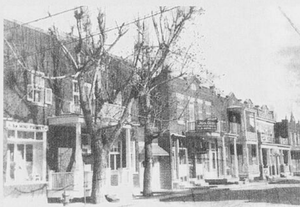
La reconstruction de la basse-ville de Terrebonne en 1923-1924, après le grand incendie du 1er décembre 1922, a été faite selon les exigences du règlement 335 adopté par le conseil municipal à son assemblée publique du 7 mars 1923. Ici, rue Saint-André, au sud de Saint-Pierre, toutes les propriétés sont conformes au règlement. On ne perd pas un pouce de terrain, il n'y a aucun escalier extérieur - on en installera plus tard, pas toujours avec l'autorisation de l'administration.
