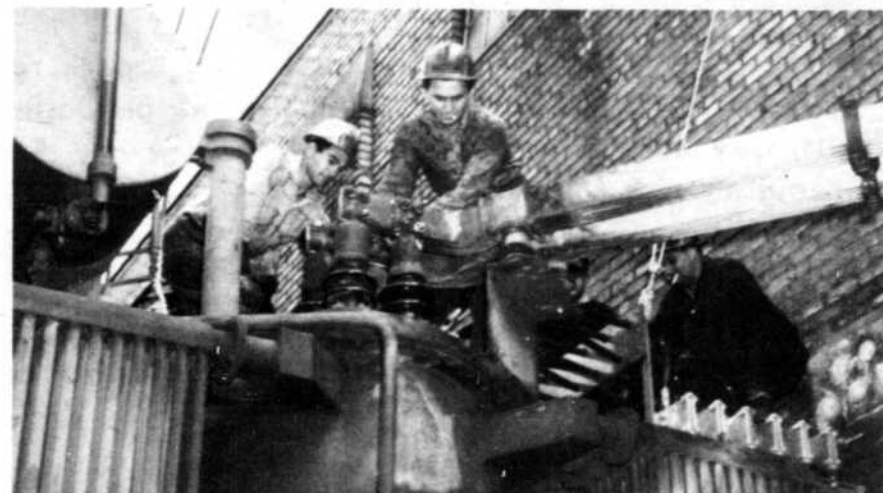
A CHAQUE redresseur correspond un transformateur — Il a aussi fallu changer les raccordements des transformateurs. C'est ce que font, de gauche à droite, MM. Clément Potvin, monteur de lignes, Jean-Eudes Girard, monteur de lignes, et Jacques Vaillancourt, mécanicien.
