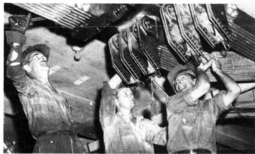
DE NOUVEAUX DISJONCTEURS — En train de poser de nouveaux disjoncteurs sur les barres-omnibus, de gauche à droite, MM. Rosaire Laliberté, mécanicien, M. Robert Martin, aide-corps de métier, et J.-B. Petit, mécanicien.
