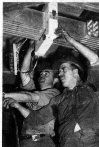
M. CAMILLE TREMBLAY ET M. OSWALD BELODEAU , deux électriciens, installent un appareil, appelé D.C.C.T., qui sert à mesurer l'intensité du courant, sur une des barres-omnibus en aluminium pouvant transporter un courant de 12,000 ampères.
