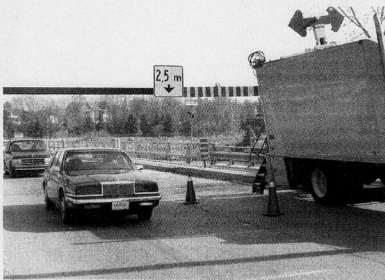
Le ministère des Transports du Québec procédait, la semaine dernière, à la pose des gabarits empêchant les poids lourds de traverser.
