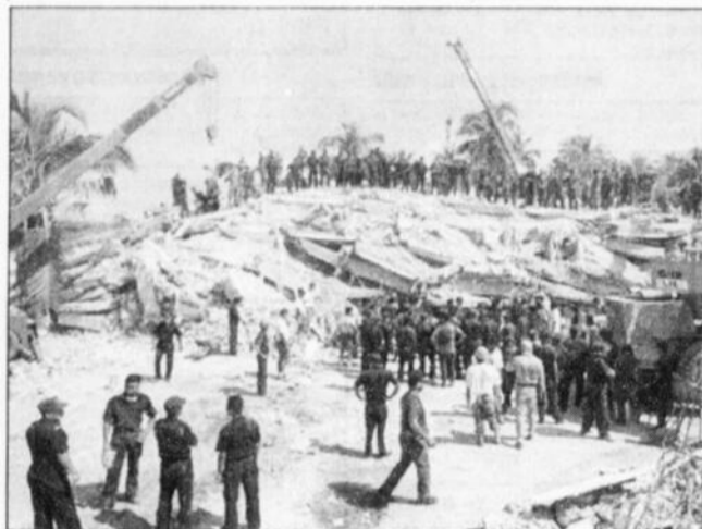
RECHERCHES - Des secouristes travaillent avec acharnement dans ce qui était l'hôtel Costa Real de Manzanillo, au Mexique, qui s'est écroulé lors du tremblement de terre. On cherche les victimes qui pourraient être enfouies sous les décombres.
