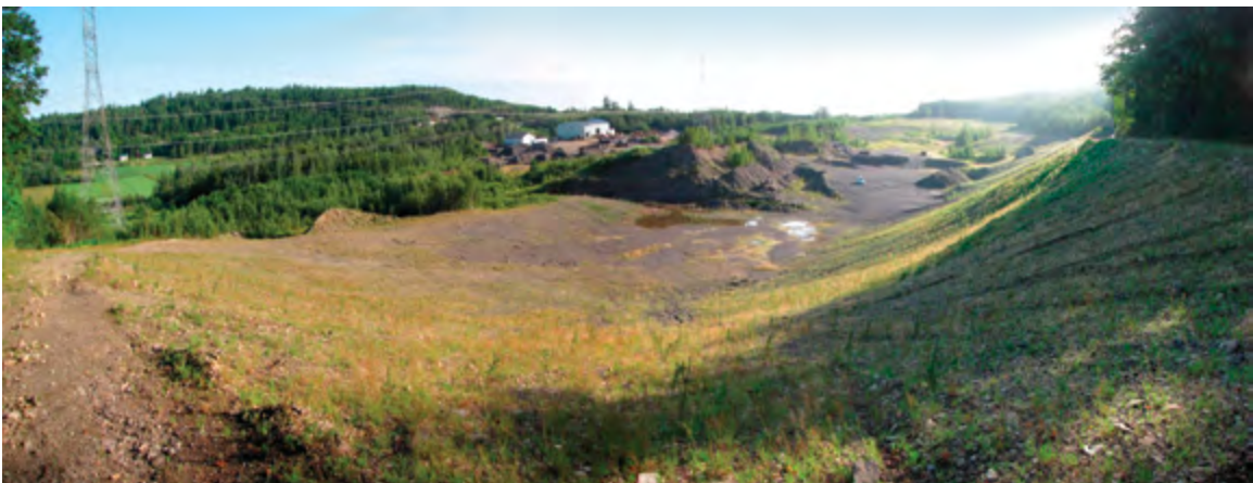
Photo 4 - Vue panoramique de parois de gravière stabilisée à 30° par rapport à l'horizontale.
