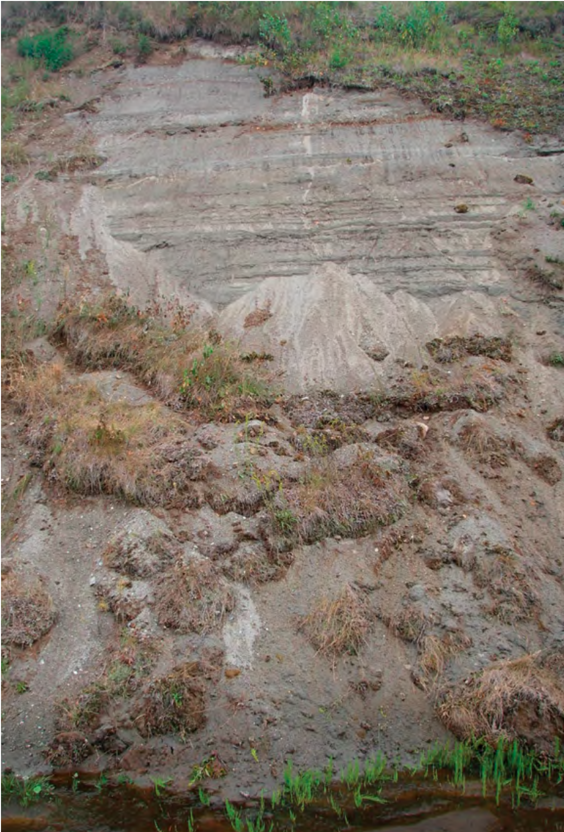
Photo 2 - Vue d'une paroi non stabilisée soumise aux processus d'érosion. Elle est le fruit d'une mauvaise planification.
