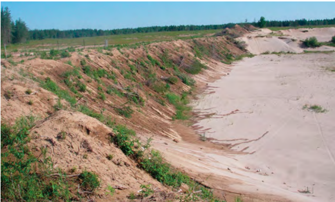
Photo 8 - Talus stabilisé et recouvert de sol arable forestier.
