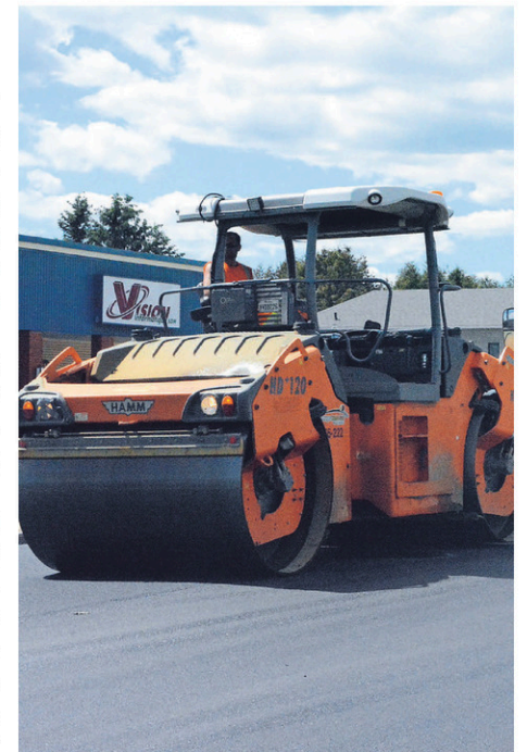
C'est l'entreprise Pavage Centre Sud du Québec qui a été le maître d'œuvre des travaux. (Photo www.lanouvelle.net)
