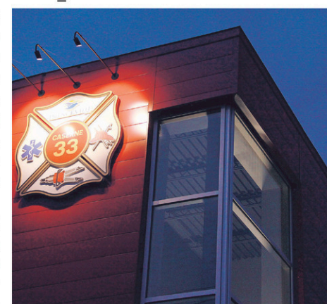
La Ville de Princeville a octroyé le contrat pour la réhabilitation du plancher de la caserne incendie faisant suite au dégât d'eau survenu en janvier 2019. (Photo gracieuSeté - archives)
