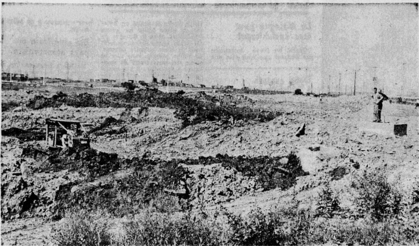
IMPORTANTS TRAVAUX — La compagnie Morin Inc., de Rivière-du-Loup, a entrepris, hier matin, l'aménagement d'une voie de recordement entre la rue Fleur-de-Lys et le Parc de l'Exposition.
