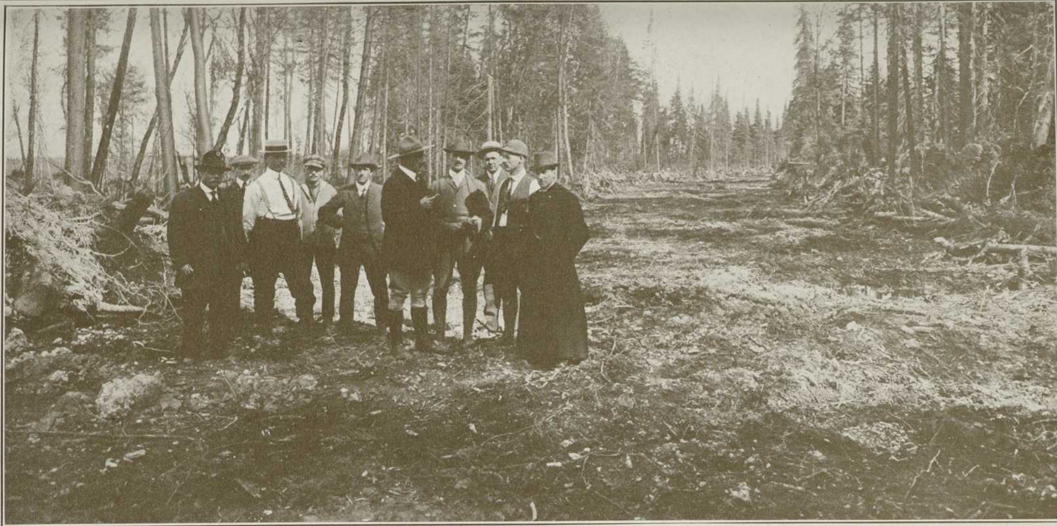
ROUTE EN CONSTRUCTION DANS LE CANTON DE SENNETERRE — 1918
