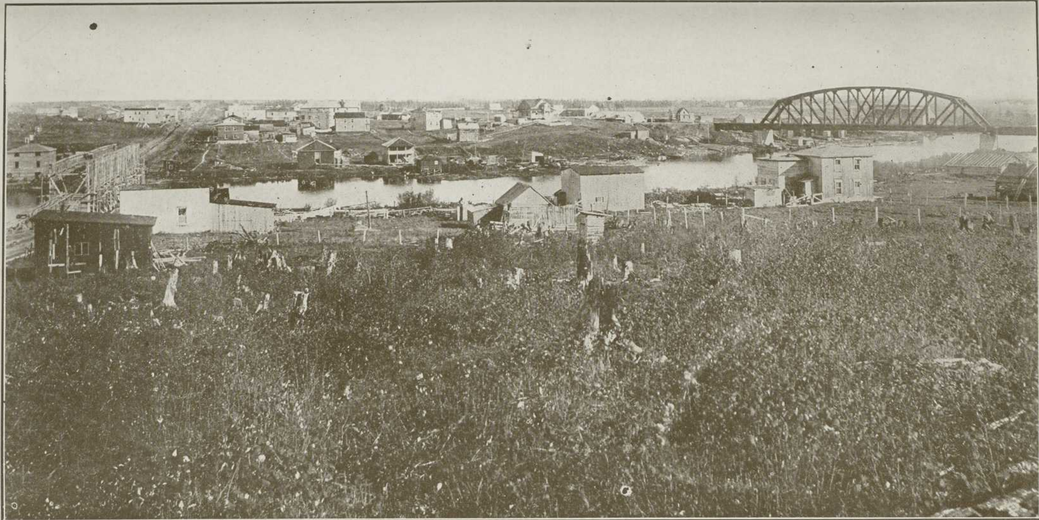
AMOS-SUR-HARRICANA — Partie sud du village
