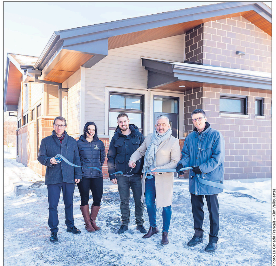
Louis Lemay, conseiller expertise et développement à la Ville, Nadia Morissette, technicienne en bâtiments, Simon Vallières, constructeur, Ian Langlois, conseiller municipal et Alain Laplante, maire, ont procédé à l'inauguration du bâtiment.
