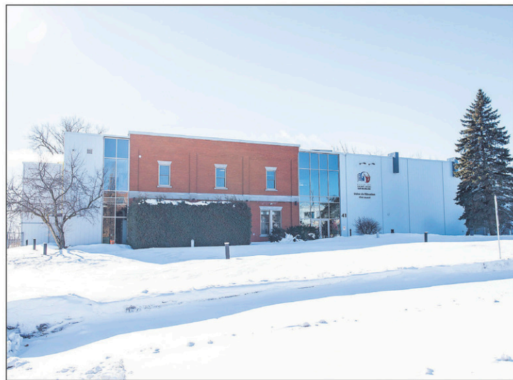
Située à l'entrée sud du Vieux-Saint-Jean, l'usine de filtration de la rive ouest peut produire un débit maximum de 75 000 mètres cubes d'eau potable par jour.
