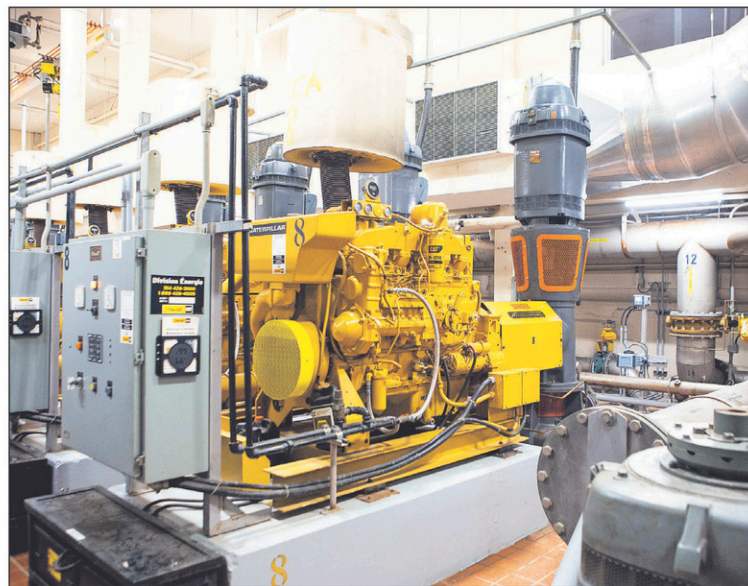
Chaque pompe distributrice est combinée à une autre au diesel pour pallier un bris mécanique ou une panne de courant.
