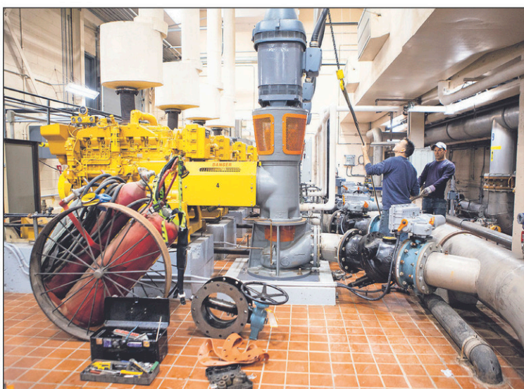
Des ouvriers s'affairent à remplacer une valve à l'aide d'un treuil dans la salle des machines.
