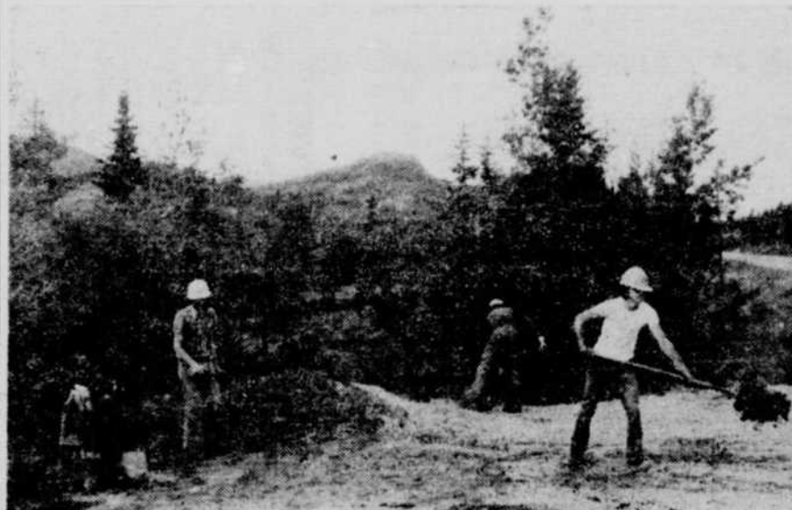
Qui dit que les jeunes ne veulent plus travailler. Ceux-ci n'ont pas hésité à prendre la pelle pour élargir le stationnement du relai routier de la rivière cachée, près des barrières du parc. (photo Michel St-Pierre)
