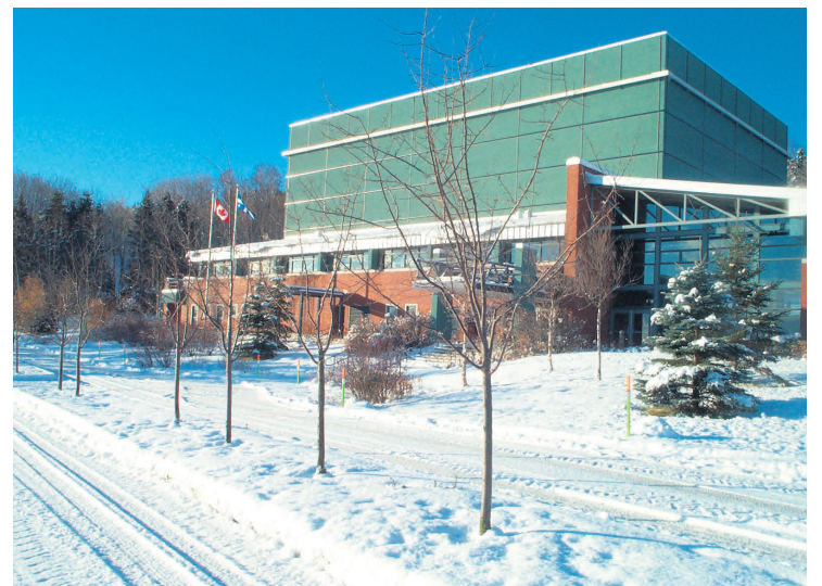
Des interventions sont aussi prévues pour la salle de concert
