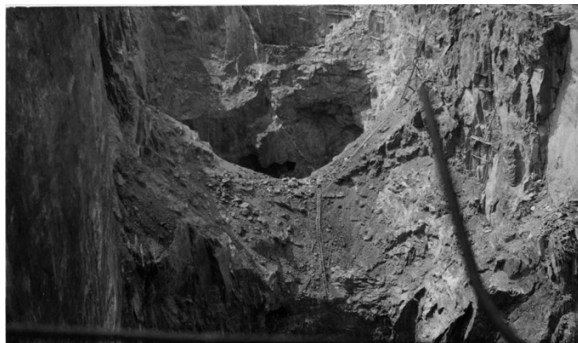
Photo 2 : vue du Glory Hole en 1942 (source BAnQ)
