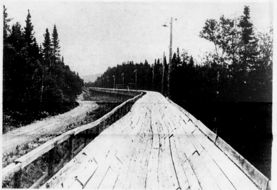
Nous avons ici un aperçu de la dalle alors qu'elle avait été asséchée pour réparations. Nous pouvons constater la pente ascendante de la dalle, disposition qui permet l'écoulement de l'eau et du bois.
