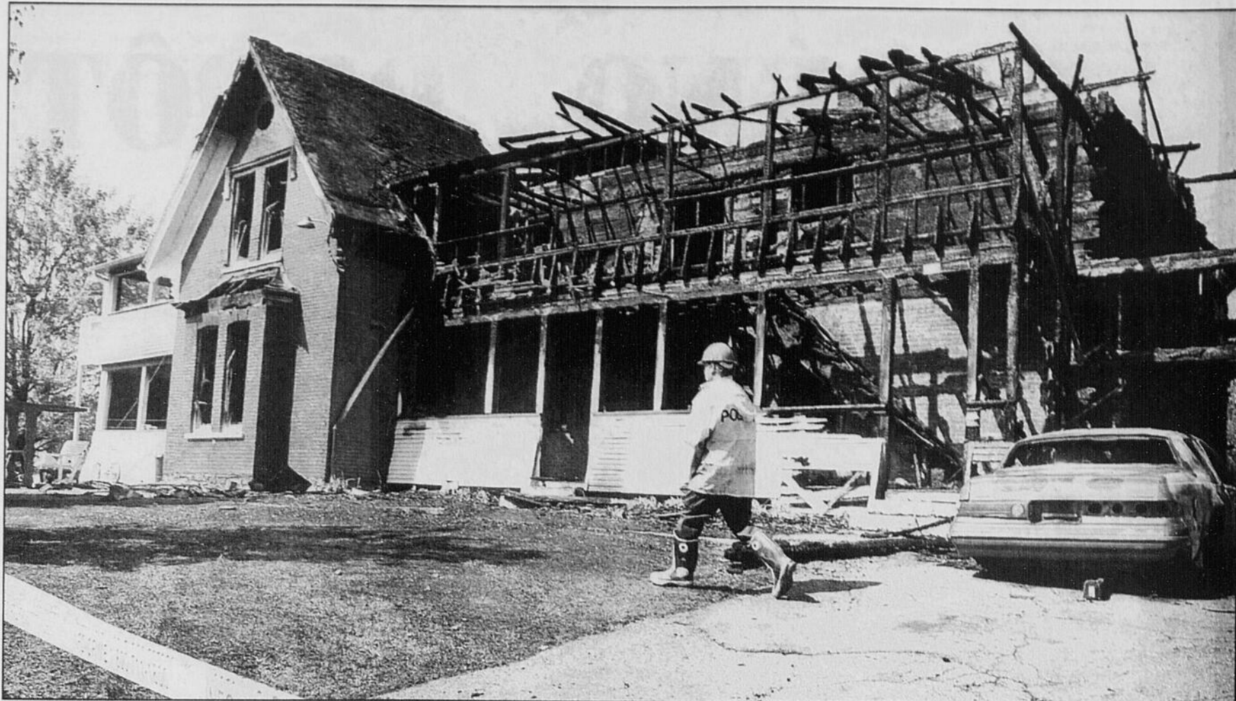
Une défaillance électrique serait à l'origine de l'incendie qui a complètement détruit une maison centenaire de la rue Cutting, à Coaticook. La maison, transformée en quatre logements, était habitée par neuf locataires. Personne n'a été blessé.
