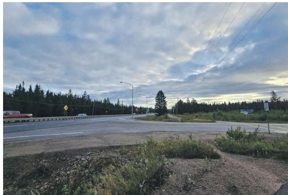
La Ville de Baie-Comeau a amené le projet d'intersection au coin de la rue des Hémérocalles en septembre 2023, dans le but de construire une nouvelle rue. Photo Karianne Nepton-Philippe
