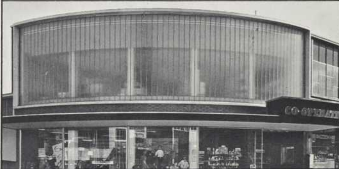
La façade courbe du second étage de cet édifice est vitrée de Profilit.
