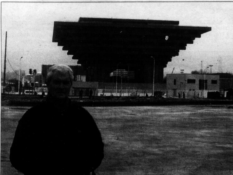
Le Pavillon de la Chine à la fin de sa construction.
