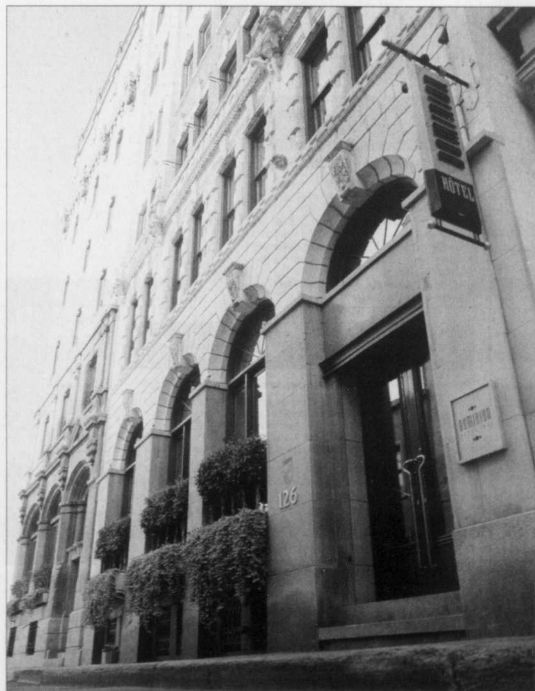
La façade de l'hôtel Dominion 1912, du Groupe Germain, à Québec.
