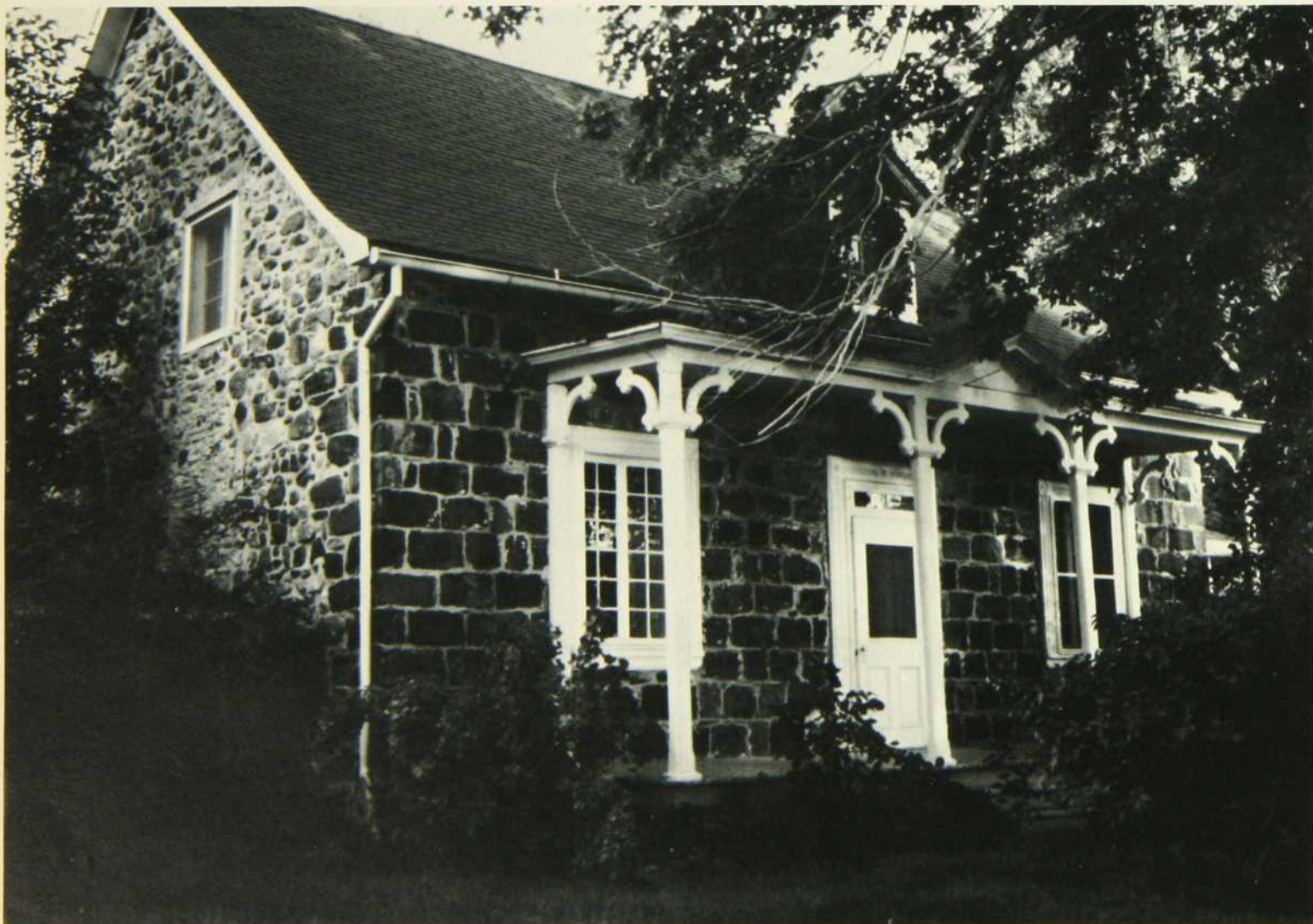
La façade de l'entrée principale actuelle, en partie rénovée.
