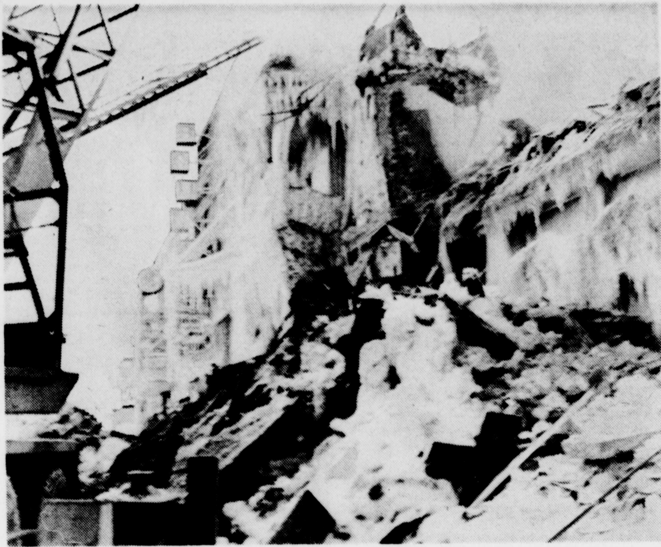
Encore au cours de la fin de semaine, on procédait au déblaiement des débris à l'endroit de l'incendie de jeudi dernier, dans le centre-ville de Joliette. On en profitait aussi pour enlever les choses pouvant être encore utiles.
