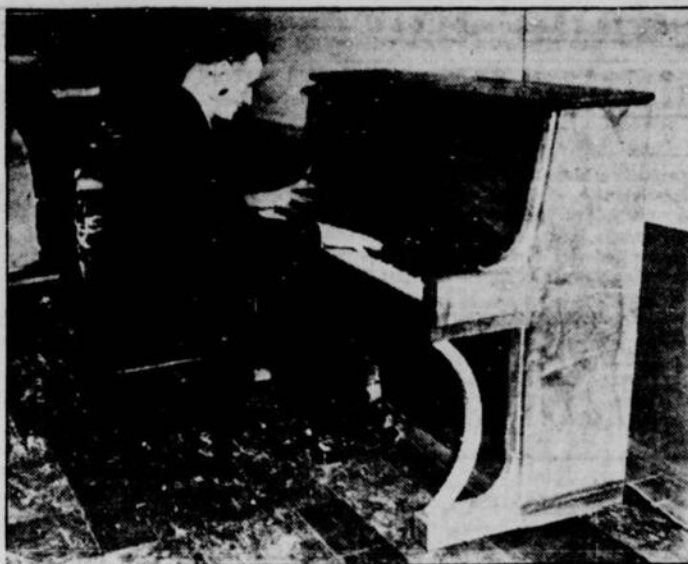
M. OSWALD MICHAUD, de Montréal, au piano sans table d'harmonie et équipé d'un amplificateur électrique qu'il vient d'inventer. Agé de 47 ans, M. Michaud s'occupe de la fabrication des pianos depuis plus de 30 ans. (Photo la "Patrie").
