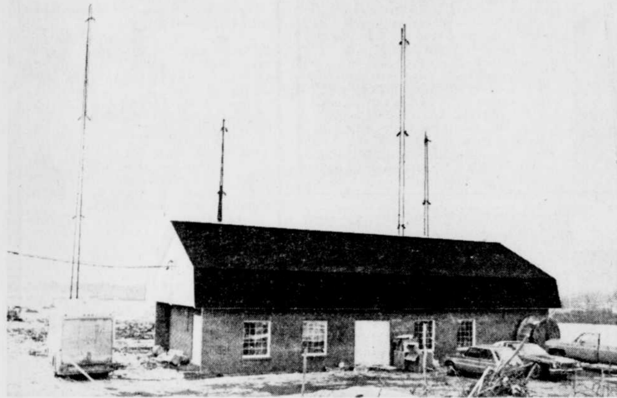
Transmetteur de la station CKCV, à Cap-Rouge.
