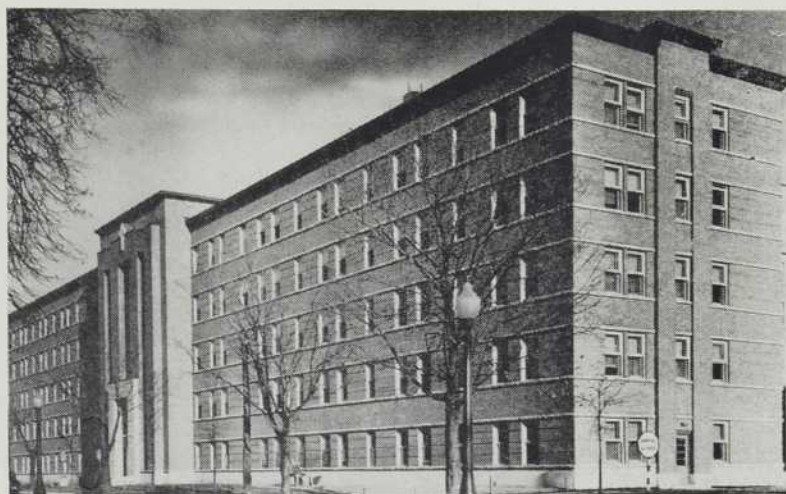
HÔPITAL ST-EUSÈBE de Joliette Architectes: MARTINEAU & TALBOT
