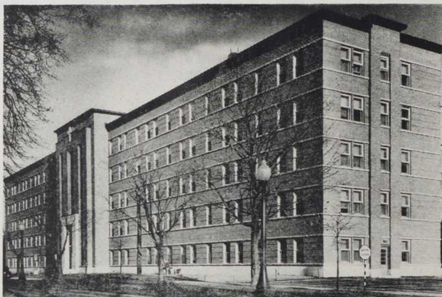
Hôpital St-Eusèbe, Joliette
