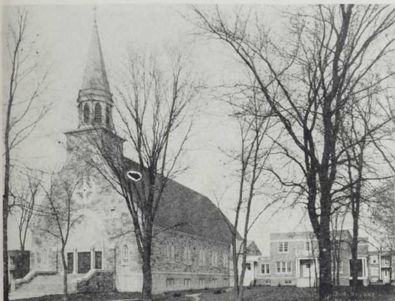
Architecte: G. R. RICHER Eglise du Sacré-Coeur, St-Hyacinthe.
