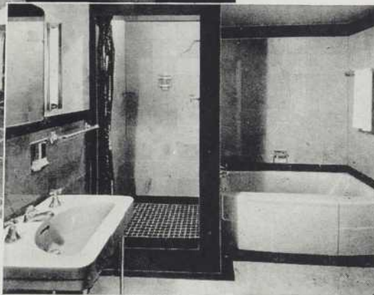
Installation "Vitrolite" dans la chambre de bain d'une résidence de Toronto.
