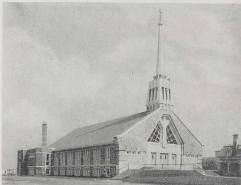
Extérieur de l'Eglise St-Dominique de Bagot — Architecte: FÉLIX RACICOT
