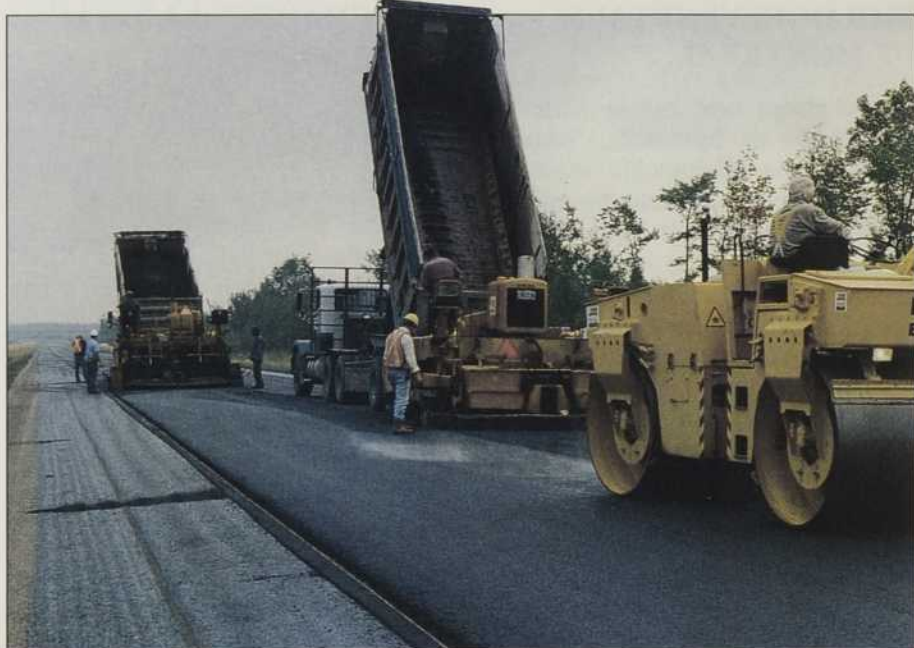
Pose d'un enrobé bitumineux auquel on a incorporé un liant polymère. Actuellement à l'essai, un tel bitume pourrait contrer les problèmes de fissuration et d'ornièrage des chaussées.
