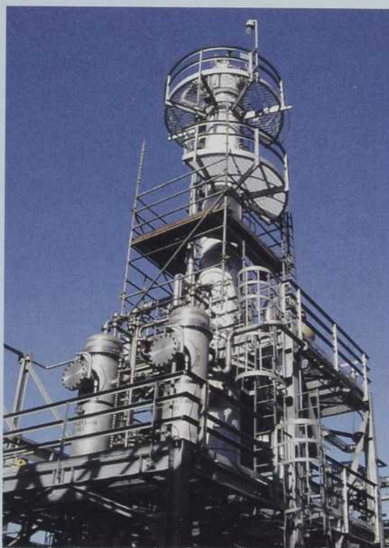
Le principe de Cansolv : capter un gaz nocif à la sortie des cheminées et l'entreposer de façon sécuritaire pour qu'il puisse servir comme matière première
