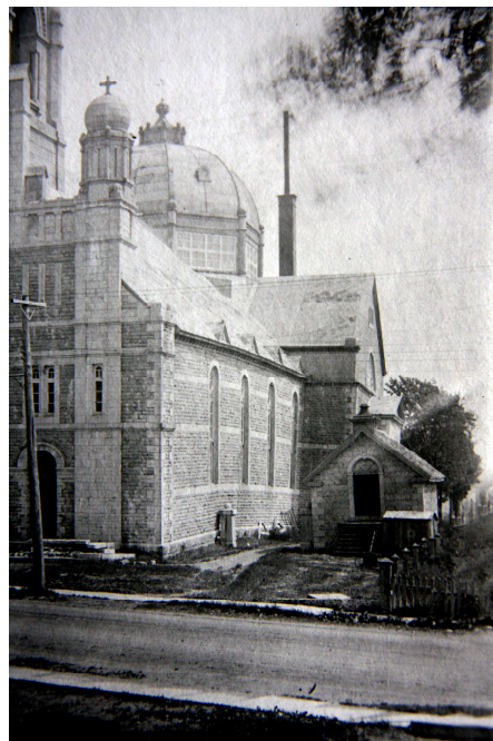
Façade latérale de la 2 e église et charnier.
