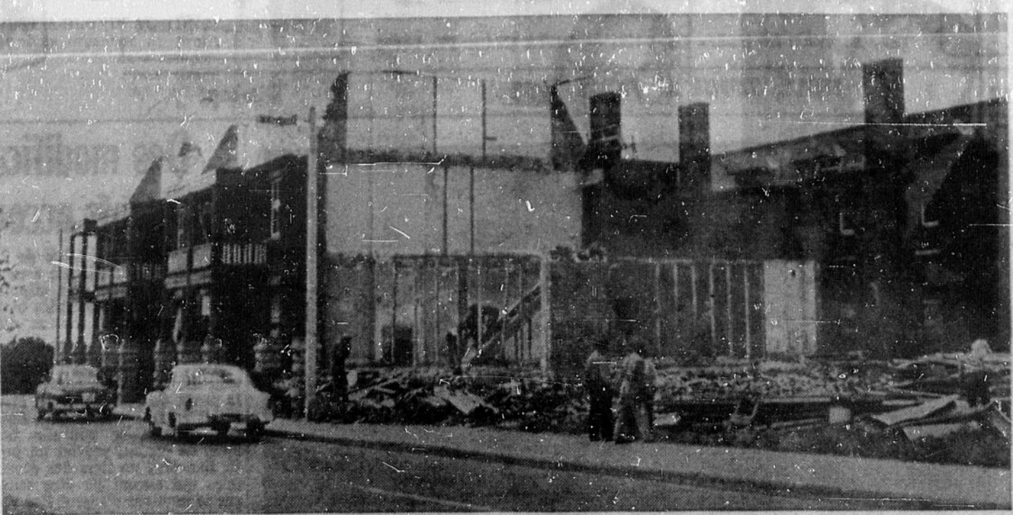
EN PREVISION DE LA CONSTRUCTION DU PONT — Cette rangée de maisons à trois étages, promenade Sussex, au sud d'une rangée semblable de la promenade Lady Grey, disparaît sous le pic du démolisseur. C'est dans le voisinage du futur emplacement de la voie ontarienne d'accès au pont interprovincial que la population réclame depuis longtemps. Quant aux endroits exacts où reposeront les extrémités du "pont des désirs", c'est l'un des grands secrets de la Commission du District fédéral qui devient la Commission de la Capitale nationale. (Photo Champlain Marcell)
