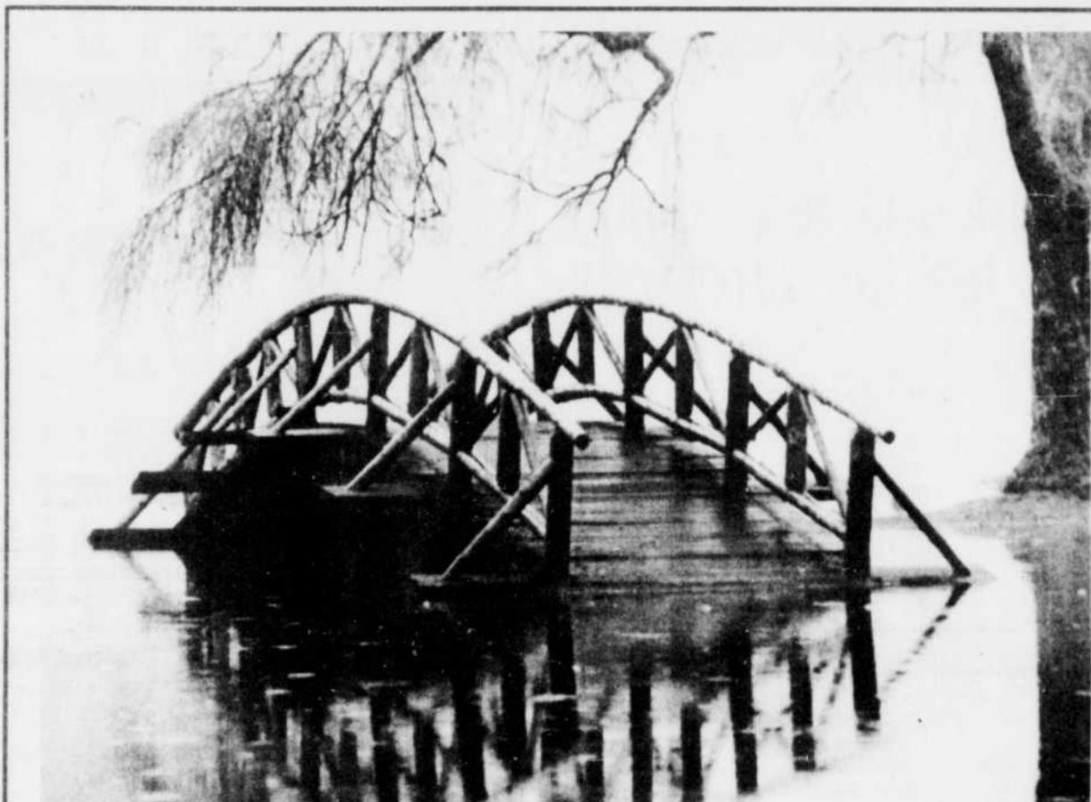
Des pluies torrentielles ont provoqué de lourds dégâts en Colombie-Britannique. Ce pont du Stanley Park de Vancouver n'était plus accessible aux piétons.
