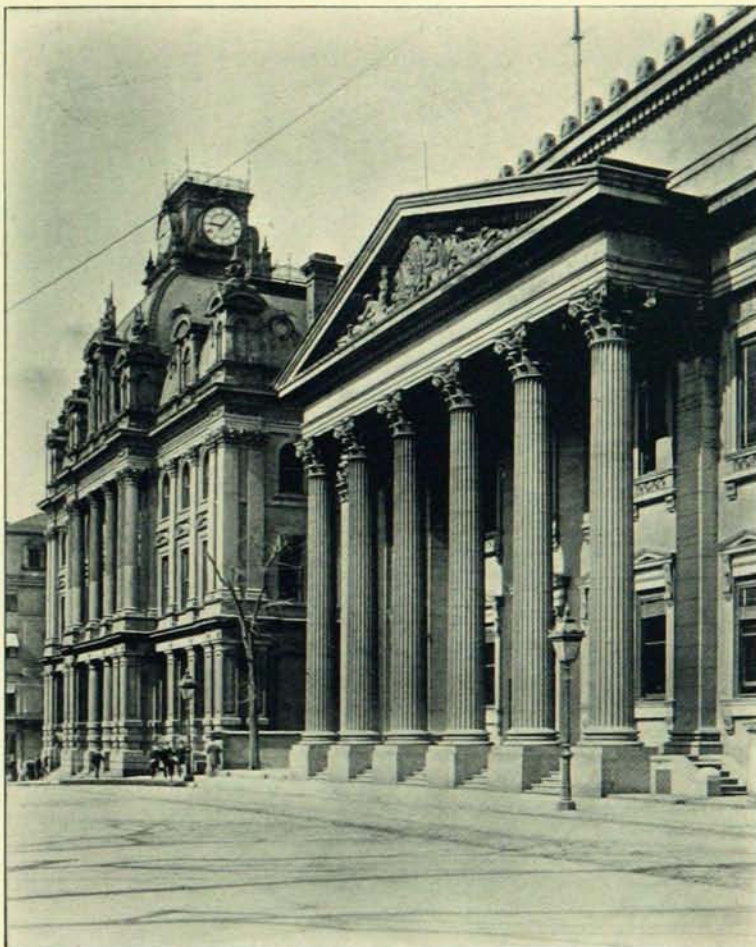
BUREAU DE POSTE ET BANQUE DE MONTRÉAL
