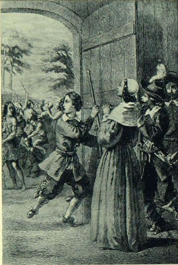
MELLE MANCÉ EN DANGER
