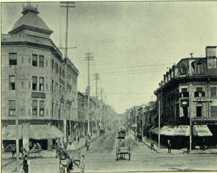
RUE ST-LAURENT, VUE DE LA RUE CRAIG
