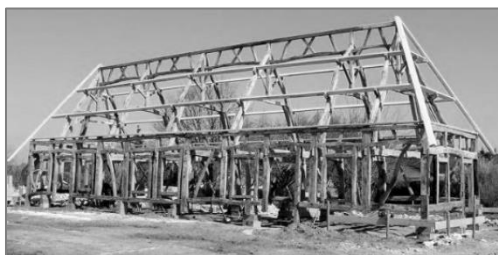
Ossature bois - maison normande
