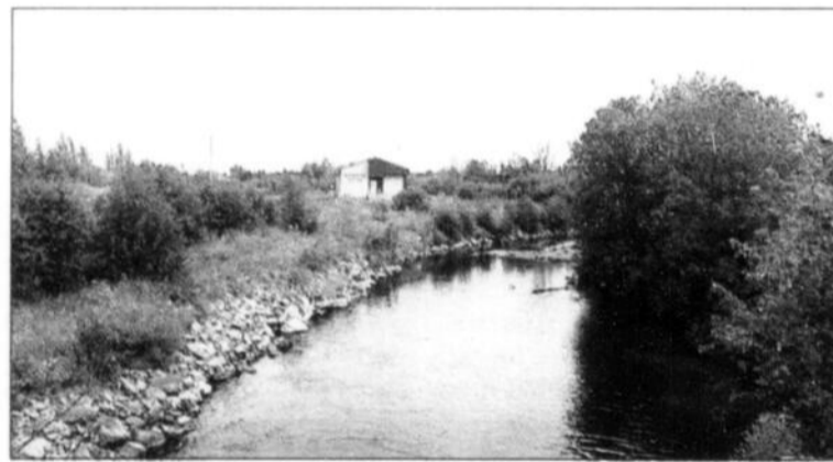
Une conduite d'eau sera construite pour amener de l'eau brute puisée dans le réservoir de la rivière à l'Ours.
