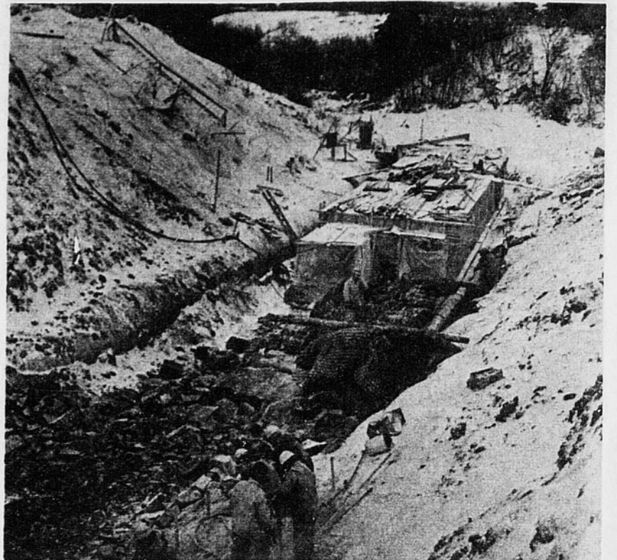
LE BOULEVARD TALBOT a été rénové à la suite d'une pétition signée par plus de 40,000 citoyens
