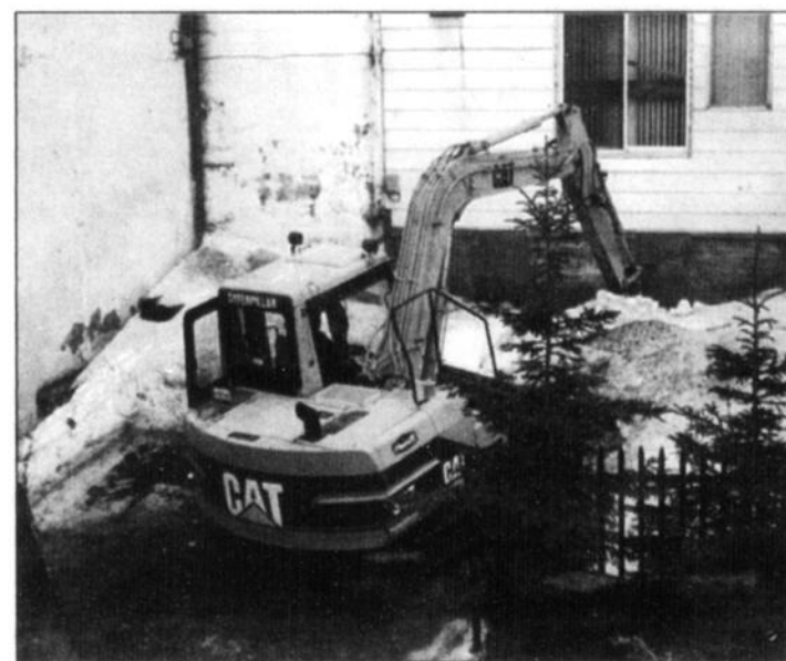
TRAVAUX — Il a fallu excaver le terrain derrière l'édifice abritant l'ancien magasin Wise pour stopper la fuite d'huile à chauffage.
