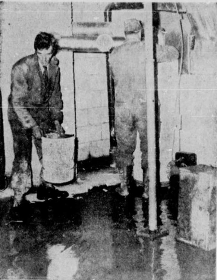
● Les retards dans la pose des services municipaux ont entraîné des pertes matérielles: les systèmes de chauffage situés dans les sous-sol de ces 120 maisons ont subi, pour la plupart, des dommages appréciables. Des plombiers s'affairent ici, à remettre une installation en ordre. Notons qu'un porte-parole de Darec construction nous a confirmé, hier, que la compagnie se porterait garante de tous ces systèmes. (Photo L'Action, Marcel Laforce)
