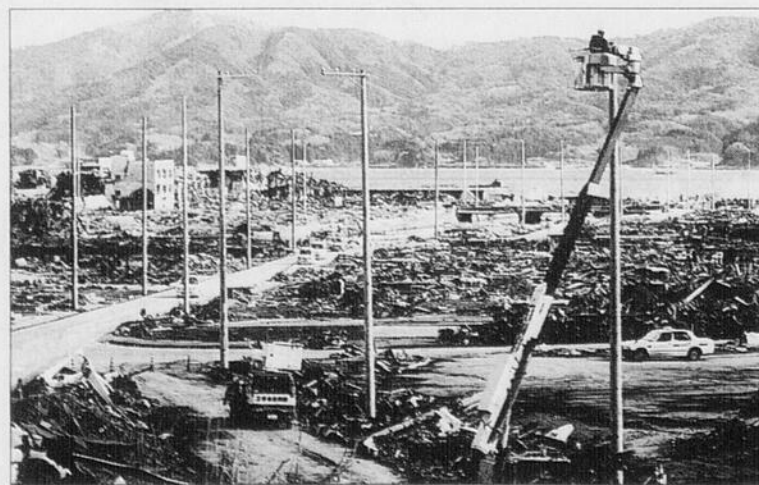
Au Japon, la reconstruction du pays se fait étape par étape. Dimanche, des poteaux d'électricité étaient érigés dans la ville partiellement ravagée de Minamisanriku.
