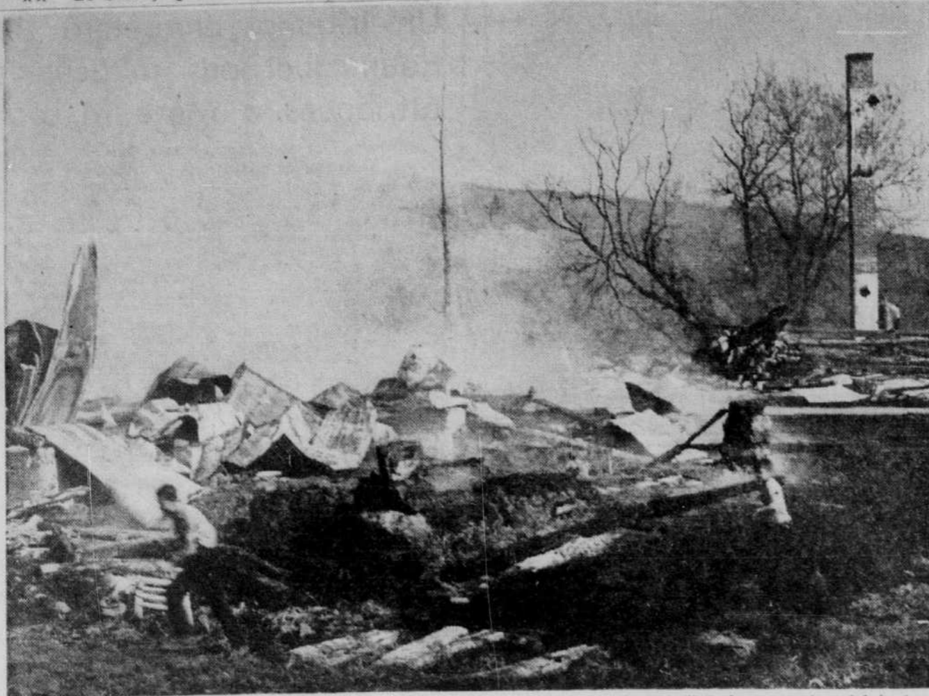
DESASTREUX INCENDIE A N.-D. DES PINS: Un violent incendie cause apparemment par une défectuosité dans le système électrique, a détruit de fond en comble la maison, la grange et un hangar rempli de bois de chauffage, propriété de M. Réal Poulin, de Notre-Dame des Pins. Seule la porcherie a pu être épargnée. Ce désastreux incendie a débuté vers 3 h. 30 p.m. mardi dernier. C'est un tout jeune enfant qui a donné l'alarme à sa mère lorsqu'il remarqua du feu du côté de
