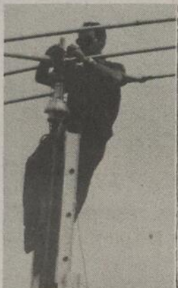
M. Jean-Nicol Dubé (Saint-Georges), installe une antenne.
